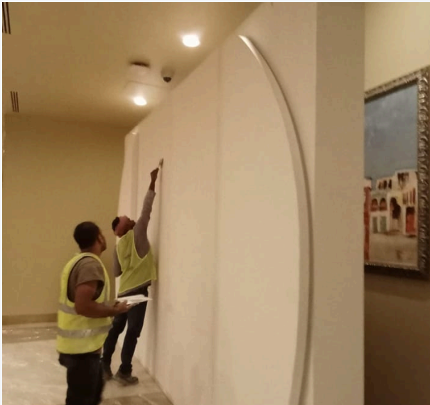
تركيب ألواح الجدار المنحني.
